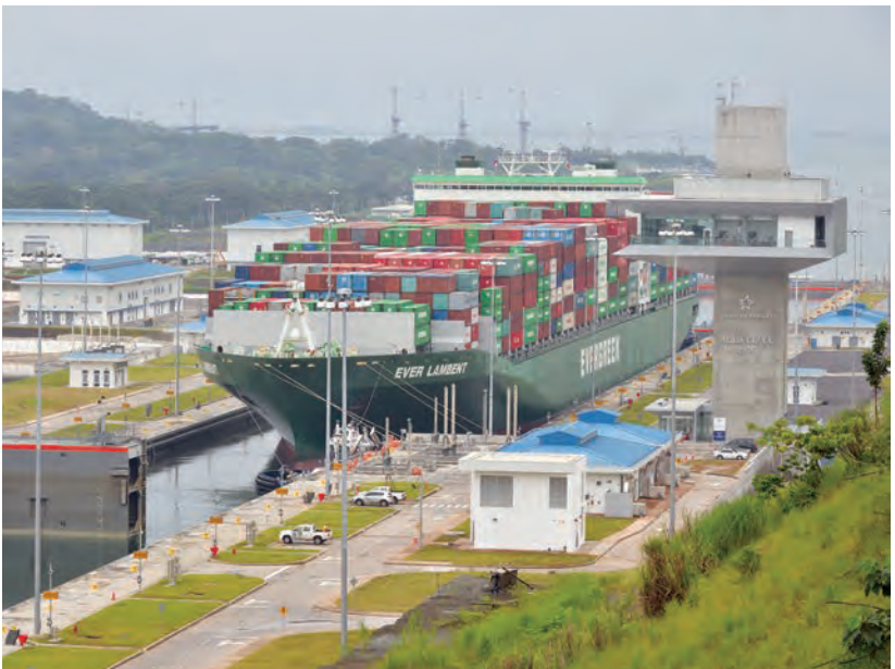
大西洋侧的阿瓜克拉拉水闸
