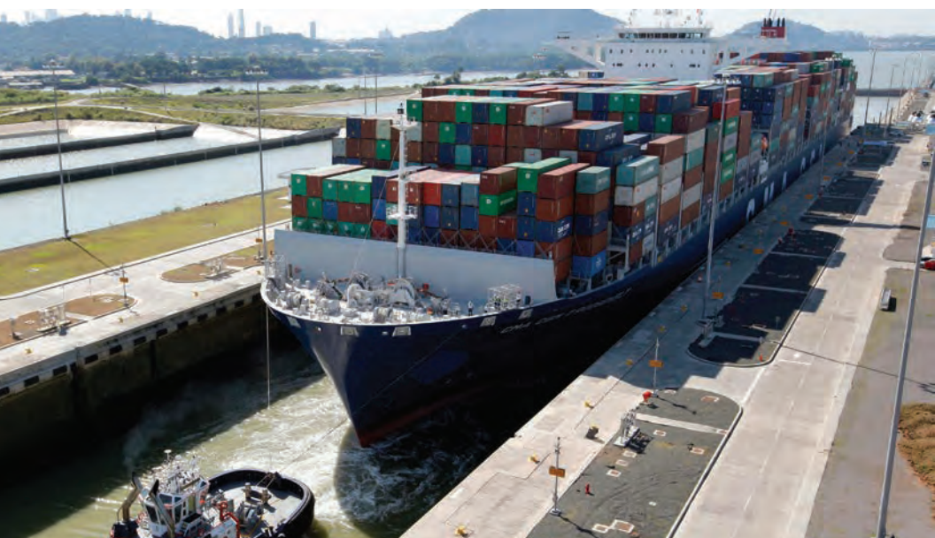
Canal ampliado, nuevas esclusas de Cocolí, en el lado Pacífico.
